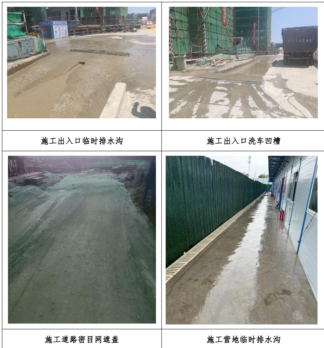
图 4.4-1 场地出入口临时措施
