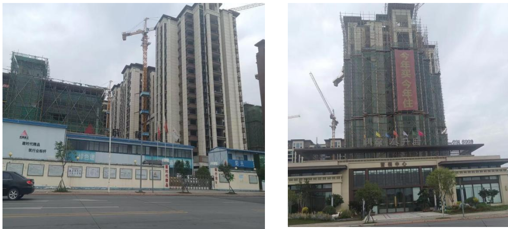
图 2.2-3 依托项目现状照片
