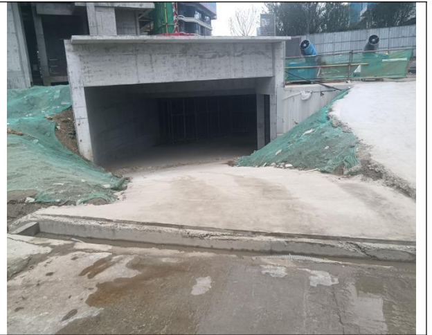
已建地下室出入口
