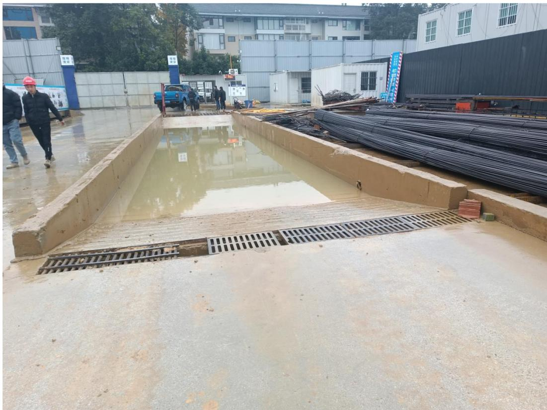
图 2.2-1 洗车凹槽布置图
